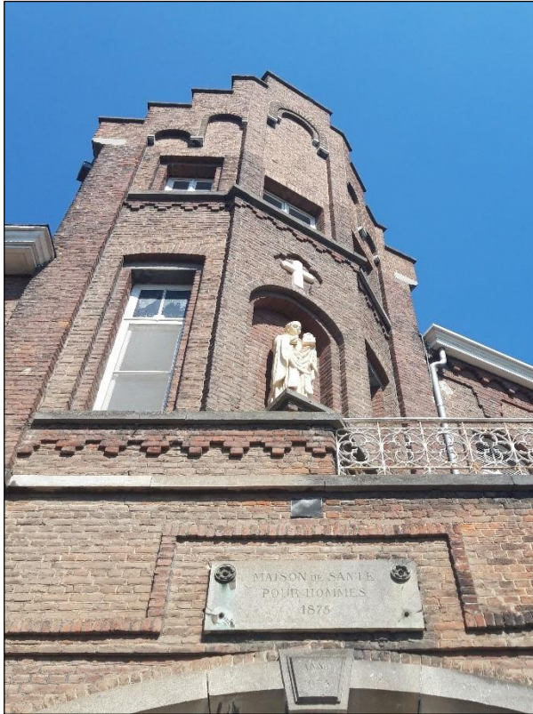
Detail van het kloostergebouw met het opschrift: 'Maison de santé pour hommes 1875'.
